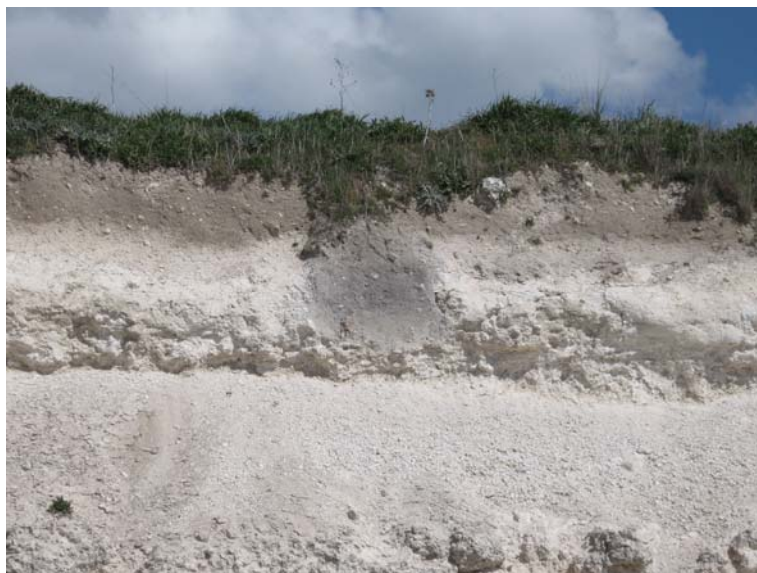
Yacimiento "Barco de los Habares" (Cuéllar). Vista general del enclave desde el noroeste y detalle de hoyo cortado por el talud de la carretera CL-601.
