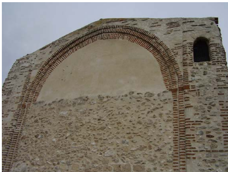
Yacimiento "San Mamés" (Campo de Cuéllar). Vista general del ábside desde el sureste y detalle del cierre occidental.
